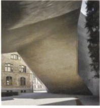
Der «Torbogen» im Neubau des Landesmuseums Zürich dient als Durchgang vom Hof in den Park. Zugleich fungiert er im Innern als Brücke mit monumentaler Kaskadentreppe. Statisch funktioniert die Brücke als Dreibein. Coverfoto von Keystone/Christian Beutler.
