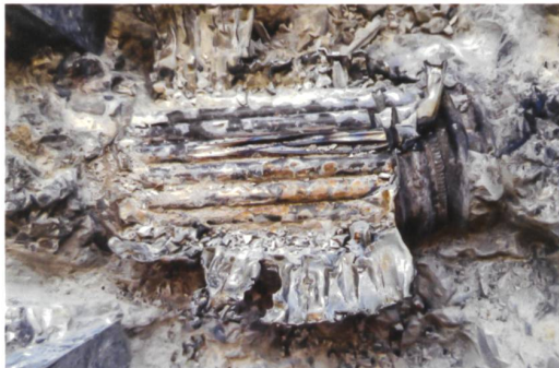
Für die Zustandsuntersuchung freigelegtes Zugseil, das aus mehreren Spanndrähten besteht.
