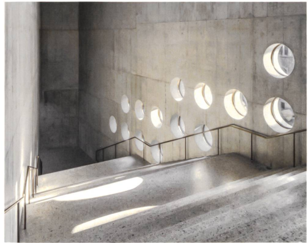
Die charakteristische Brücke aussen ist im Innenraum eine monumentale Kaskadentreppe , über die die Besucher von den Dauer- ausstellungen im Erdgeschoss zu den Wechselausstellungen im zweiten Obergeschoss gelangen. Der Sichtbeton ist etappiert – der Monolith wurde mit etwa 300 Betonieretappen zu einem monolithischen Bauteil erstellt. Durch die Bullaugen gelangt Tageslicht ins Innere, zugleich zeigt sich der Altbau von aussen.
