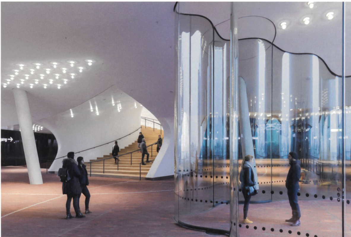
Wie eine finnische Vase mäandert die Glasfassade zwischen Plaza und Terrasse. Auf diese Weise hält sie dem Winddruck stand.
