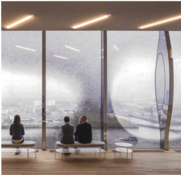
Blick durch die mit Siebdruck belegten Scheiben, rechts eines der nach aussen gewölbten Elemente, in denen die Lüftung untergebracht ist.
