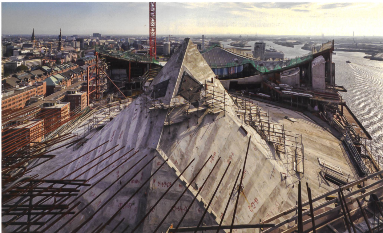
Die Saaldecke des grossen Konzertsaals von aussen: Sie geht über in die geometrische Form des charakteristischen Gebäudedachs. Die Spitze dient diesem als zentrales Auflager.
