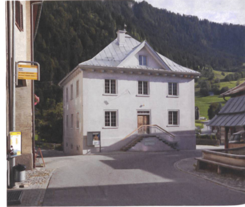
2_ Das alte Schulhaus, vom Dorfplatz aus gesehen, nach der Renovation.
