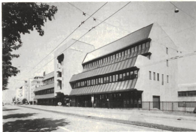
Grundrissanlage von Südosten. Auf dem westlichen Trakt am Dachgeschoss befinden sich Sonnenkollektoren, auf dem östlichen Teil besteht die Möglichkeit, für den späteren Einbau weiterentwickelter Kollektoren. In den Brüstungen der 1. und 2. Obergeschosse erkennt man die Luftkollektoren
