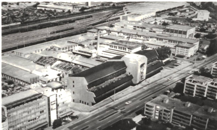
Flugaufnahme der Gesamtanlage vom Südwesten
