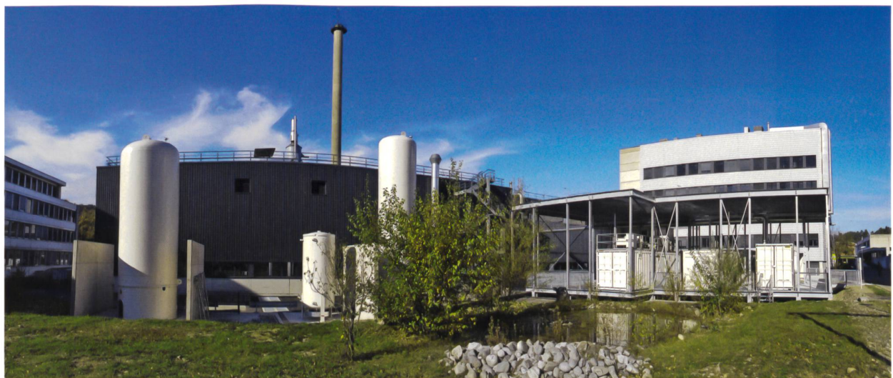
Die Power-to-Gas-Versuchsanlage am Paul-Scherrer-Institut ist Bestandteil einer Energiesystem-Integrationsplattform. Im Vordergrund steht das Erforschen von Speichervarianten und der energetischen Nutzung von Biomasse.
