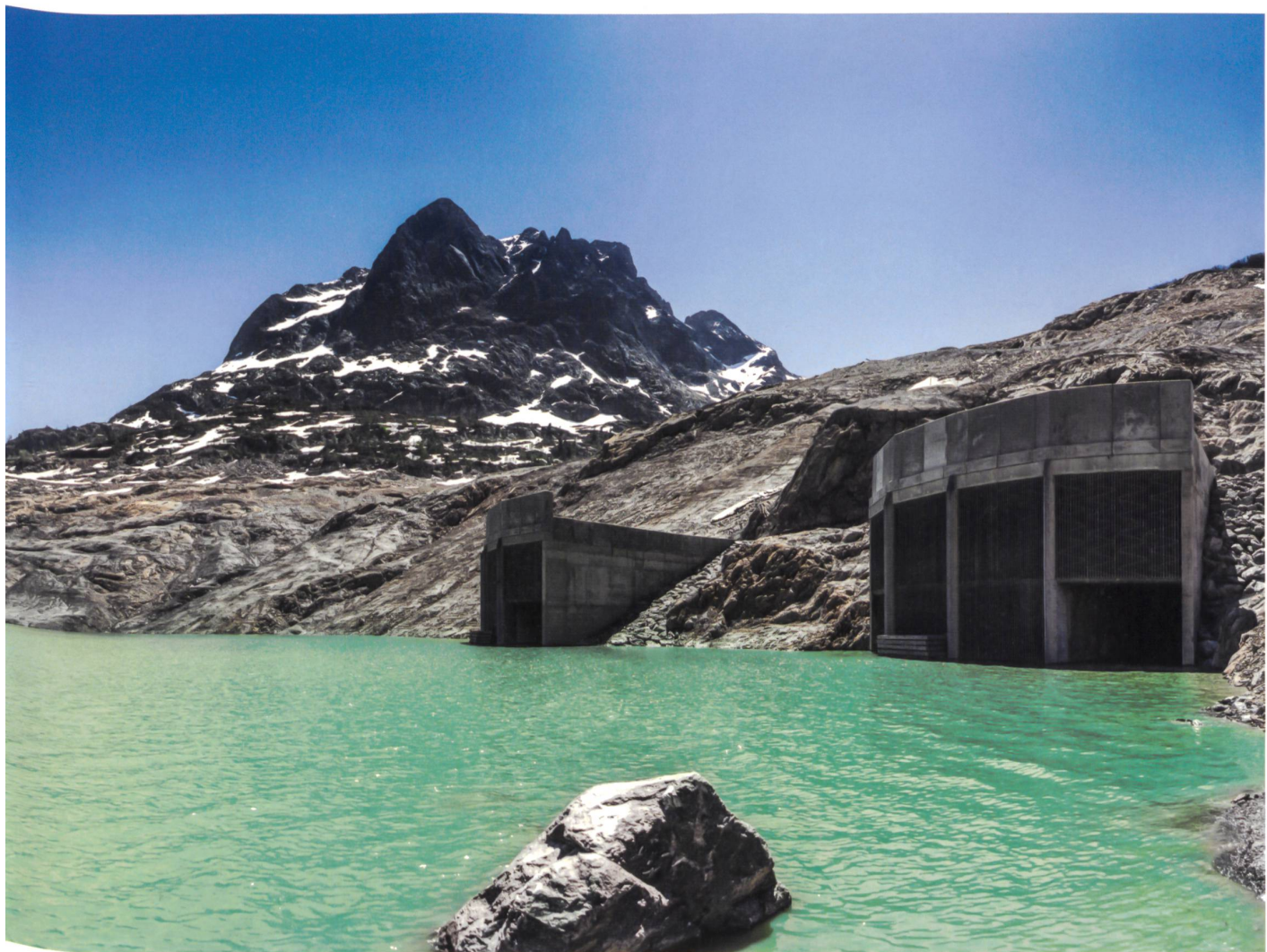
Nant de Drance: Stausee Eموsson mit Bogenstaumauer und Ein- und Auslaufbauwerken zum unterirdischen Pumpspeicherkraftwerk.
