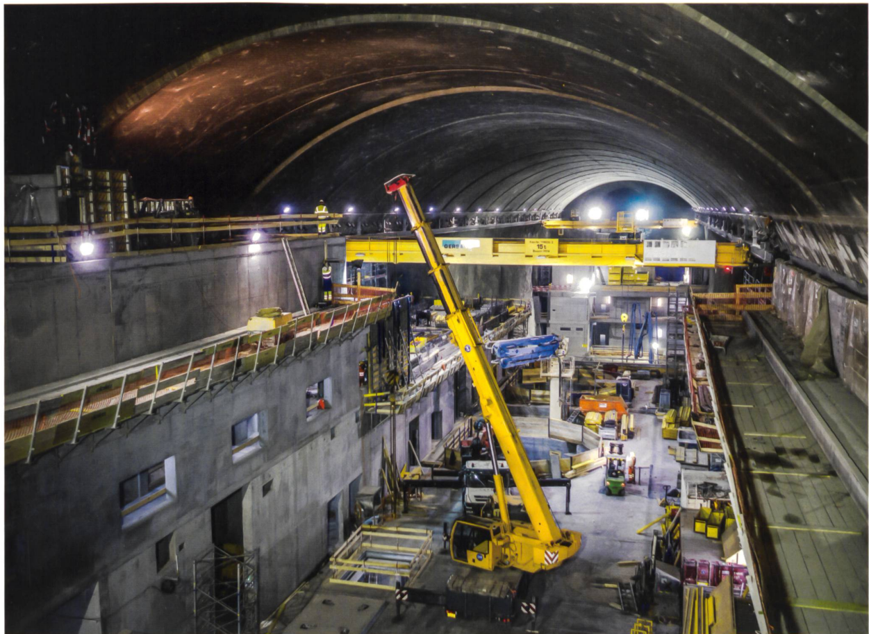
Nant de Drance: Ausbau der Maschinenkaverne. In der Bildmitte zwei der sechs Schächte für die Aufnahme der Maschinengruppen.
