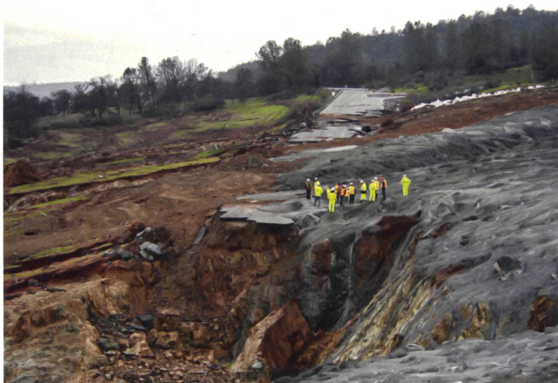
Fels, Gestein und Zementschlamm sollen die von der Erosion geschwächten Hänge unterhalb der Staumauer stärken.
