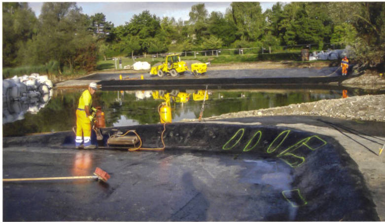
Einbau der Asphaltabdichtung im Uferbereich des Grossweihers.
