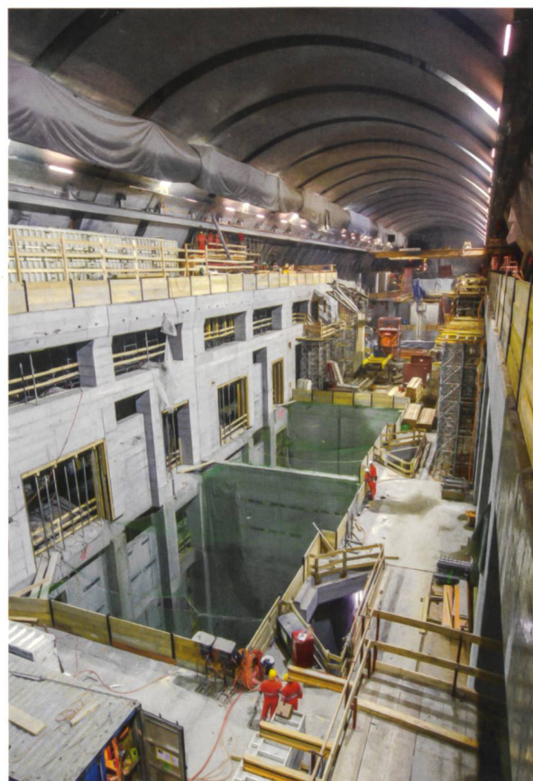
Die Betoneinbauten der Maschinenkaverne mit zwei der vier Schächte zur Aufnahme der Maschinengruppen.
