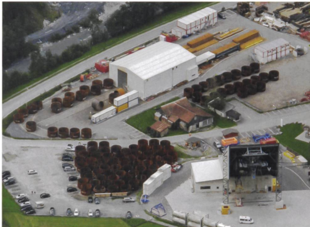
3 m lange Rohrstücke zur Panzerung der Stollen warten im Talboden auf ihre Luftreise mit der Bauseilbahn 1 (vorn rechts)
