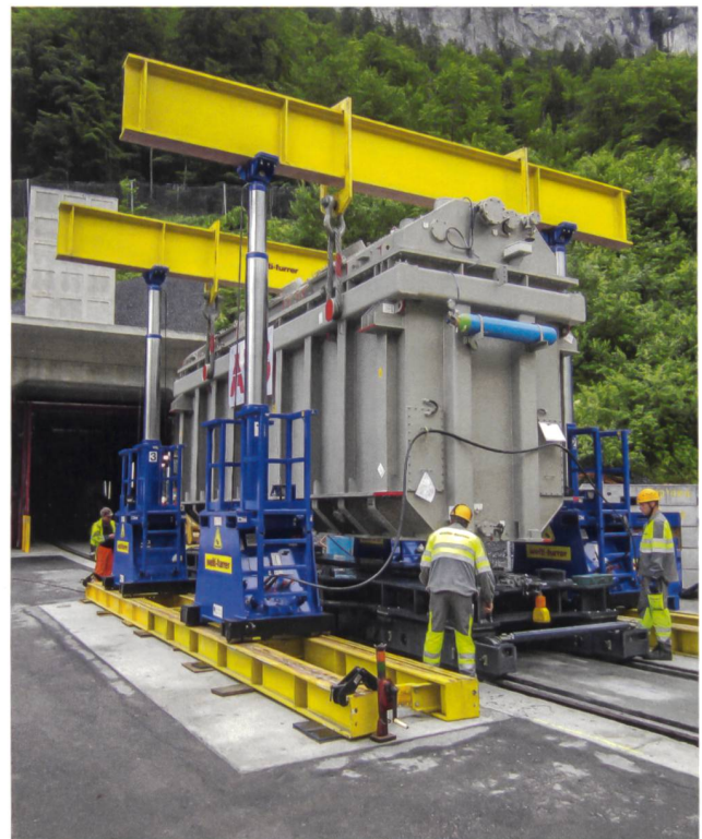
Das Spiralgehäuse einer Pumpturbine dient zur Optimierung der Anströmung der Turbine (links). Ein Maschinentransformator wird auf die Standseilbahn zur Fahrt in den Berg verladen. Durch den hier im Talboden beginnenden Zugangsstollen 1 führen auch die Hochspannungsleitungen zum Kavernenkraftwerk (rechts).
