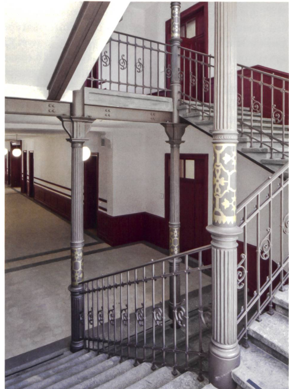
Raumhöhen von 3.80 m und Ornamente aus Blattgold: Das Schulhaus ist ein Vertreter der um die Wende zum 20. Jahrhundert entstandenen «Schulpaläste». Eine der Blattgoldbemalungen an den Säulen der Treppenhäuser ist noch erhalten und wurde im Zuge der Sanierung gesäubert, die anderen mit Goldfarbe nachgezeichnet.
