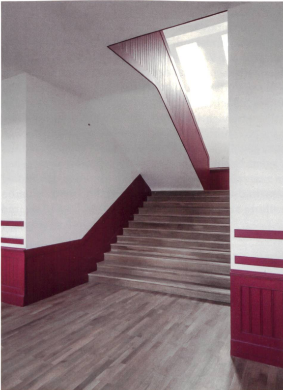
Aufgang vom 3. OG ins DG. Die neue Treppe befindet sich an der gleichen Position wie die Eingangstreppe im EG. Die Stufen im unteren Teil können zum Sitzen genutzt werden. Die Lamperien des Altbaus wurden an den neuen Wänden weitergezogen, sind hier aber flächenbündig mit den vergipsten Wänden ausgeführt.
