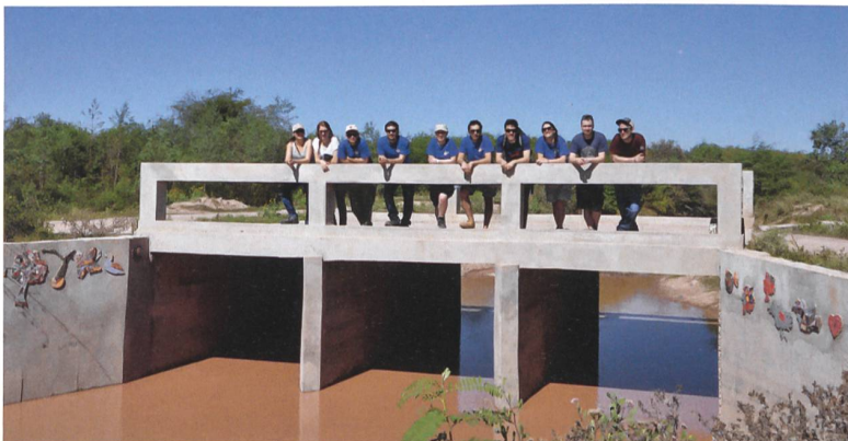
Mitglieder von Ingenieure ohne Grenzen auf der grösseren der beiden Brücken, die sie in Colonia Dora bauten. Dieses Bild entstand im Frühling 2015 bei Beginn des nächsten Projekts in der Region.
