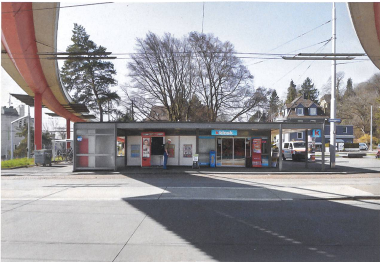
Mit dem 1956 fertiggestellten Verkehrspavillon am Bucheggplatz in Zürich konnte Jacques Schader die transparente Leichtigkeit der amerikanischen Pavillonarchitektur umsetzen, der Einfluss von Ludwig Mies van der Rohe ist ersichtlich. Die Situation zur Entstehungszeit (oben) und heute (unten).
