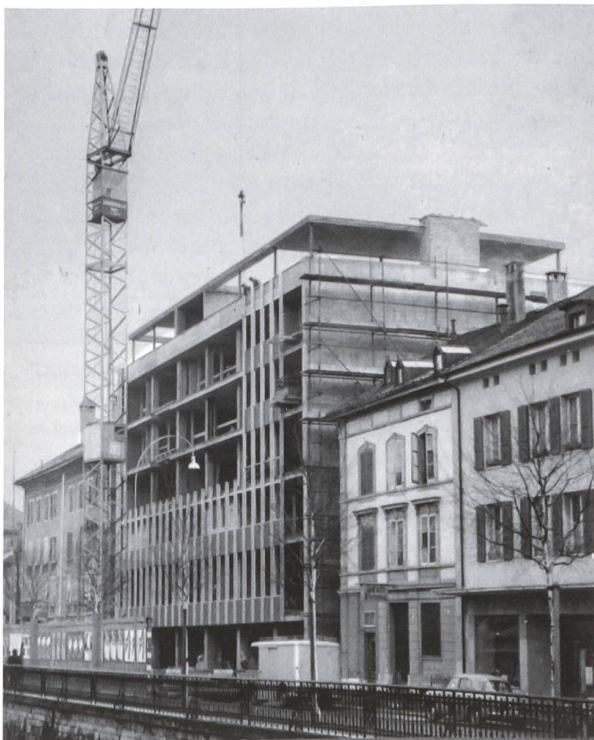
Oben: Montage der ersten Curtain-Wall-Fassade im Kanton Bern. Historische Aufnahmen zeigen, wie visionär sich das Farelhaus im Gegensatz zu seinen Nachbarn präsentierte.
