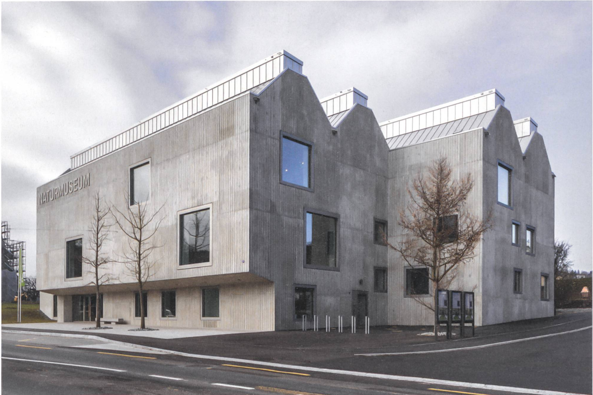
Im wechselnden Licht zeigt sich der Charakter der gerillten Betonfassade. Die Rücksprünge im Volumen bilden Plätze um das Haus.
