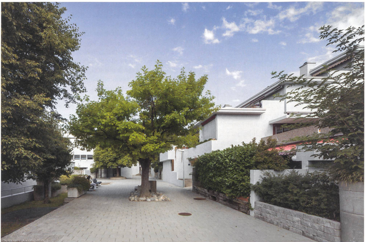
Siedlung Brügglacher in Oberrohrdorf: Der öffentliche Platz bildet das Herz der Siedlung. Die angrenzenden privaten Aussenräume sind geschützt und nicht einsehbar.
