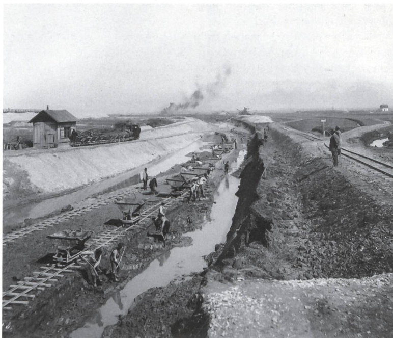
Arbeiter beim Bau des Fussacher Durchstichs im Jahr 1896.
