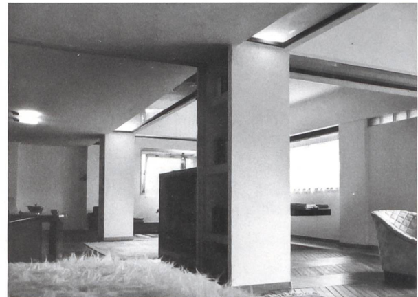
Wohnraum: Die Pfeiler dienen als Regale, die Beleuchtung ist in den transluzent verglasten Deckenkassetten integriert.
