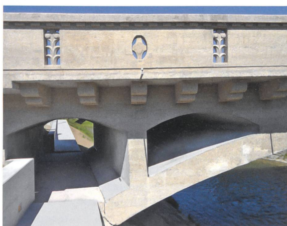
Neu geschaffene Fussgängerunterführung unter der renovierten Guillermieux-Brücke.
