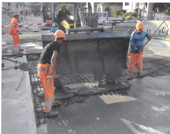
Einbau des Zuggurts aus bewehrtem UHFB.
