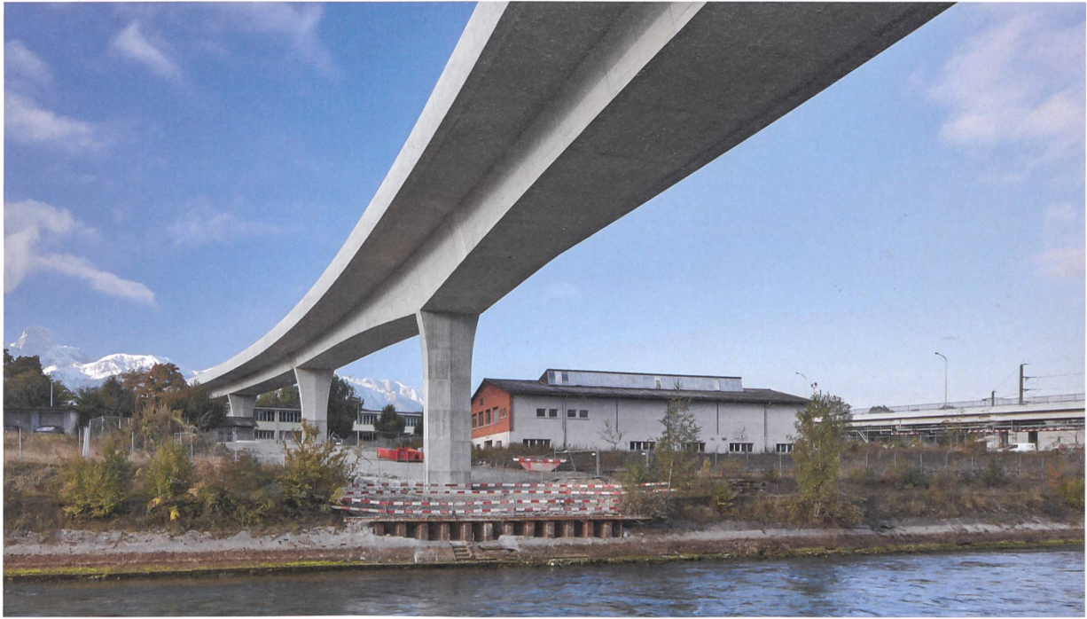
Untersicht der Brücke am Südufer der Aare.
