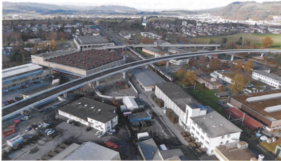
Der Bypass liegt an der Schnittstelle heterogener Landschafts- und Siedlungsstrukturen : Die vorgegebene, bogenförmige Linienführung zieht sich zentral über das grossmasstäbliche Industrieareal der kleinen Allmend (links), quert die Bahn und die Aare und wird im Norden in die Nahtstelle zwischen offener Landwirtschaftsfläche (Glattmüli) und Industrieareal (AMP-Areal) eingeführt.
