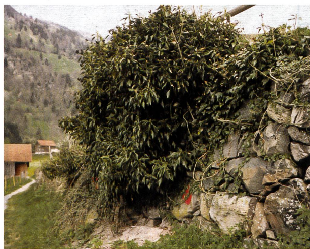
Wir verglichen auch verschiedene Mauern an unserem Ort: Betonmauern und Natursteinmauern.
