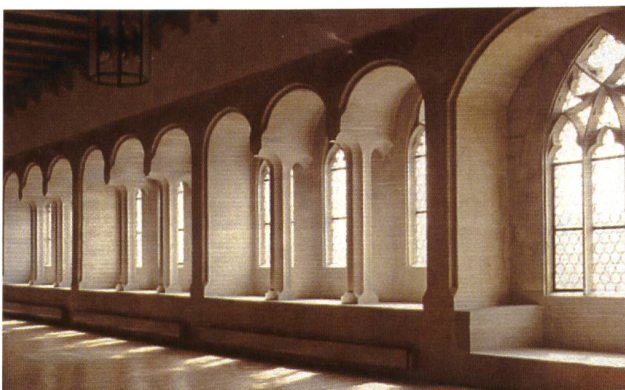
Gotisches Fensterband, das nach 1509 zugunsten von Schiesscharten zugemauert, anlässlich der Sanierung von 1985 aber neu hergerichtet wurde.
