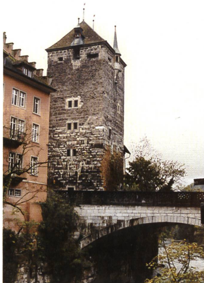
Aarebrücke (bis 1578 aus Holz) und «Schwarzer Turm», das Wahrzeichen der «Prophetenstadt». Eindrücklich sichtbar sind beim Turm die unterschiedlichen Maurertechniken aus den verschiedenen Epochen (untere Hälfte aus römischer Zeit).
