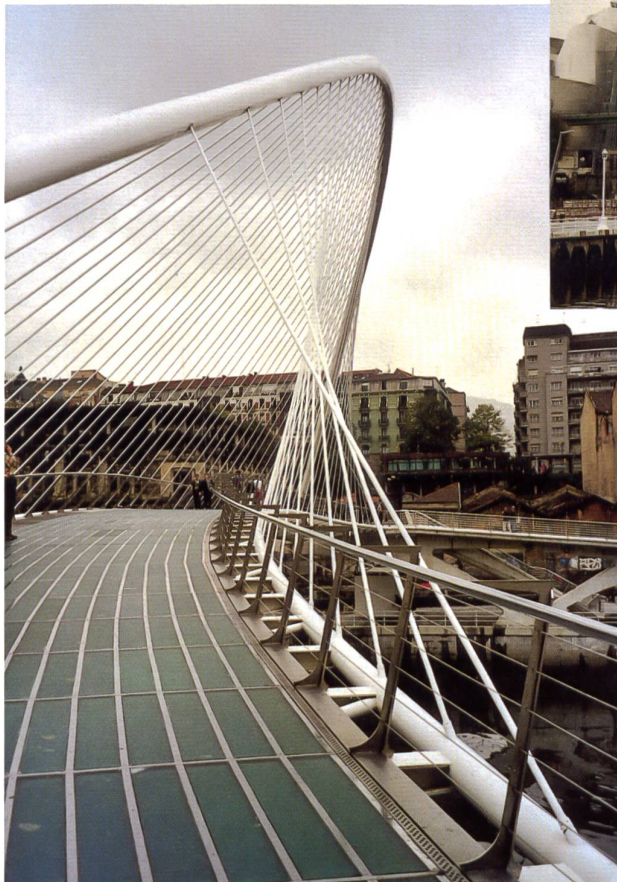
Faszination Brücke: Zubizuri-Brücke von Galatrava in Bilbao
