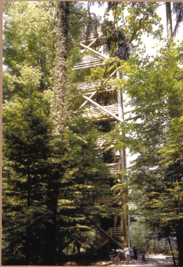
■ Insgesamt wurden 110 m 3 Holz für den Turm benötigt. Beim Besteigen sollen sich die Schülerinnen und Schüler rücksichtsvoll und vorsichtig verhalten.
