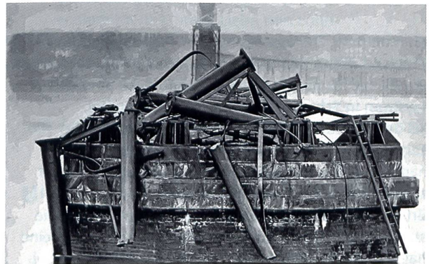
Die eingestürzte Brücke.
