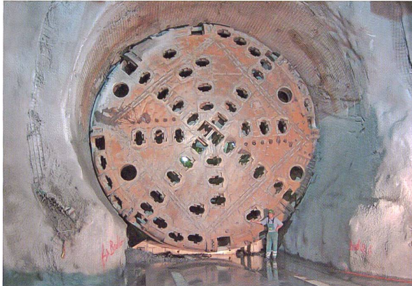
Moderne Tunnelbohrmaschine «Heidi».
