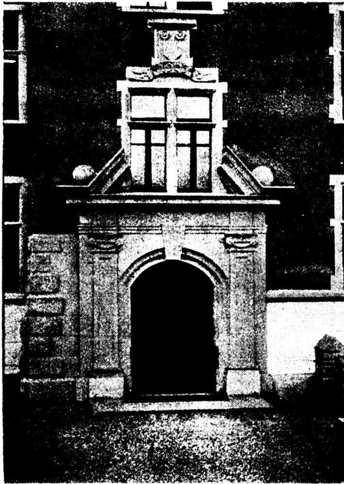
Neues Schulhaus von kath. Rapperswil: Hauptportal.
