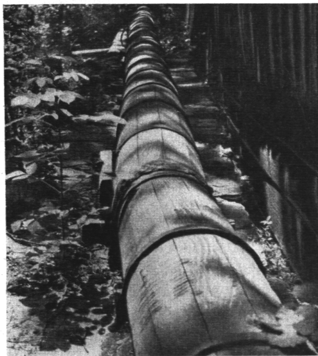
Holzröhren leiten das warme Wasser von der Quelle zu den Bädern
