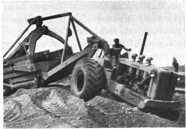
Interkontinentaler Flughafen Zürich. Der von einer Tourepull-Zugmaschine gezogene, 10 Tonnen schwere »Scraper« ist ein Bodenhobler, der zu Planierarbeiten auf leichtem und mittelschwerem Untergrund eingesetzt wird.
