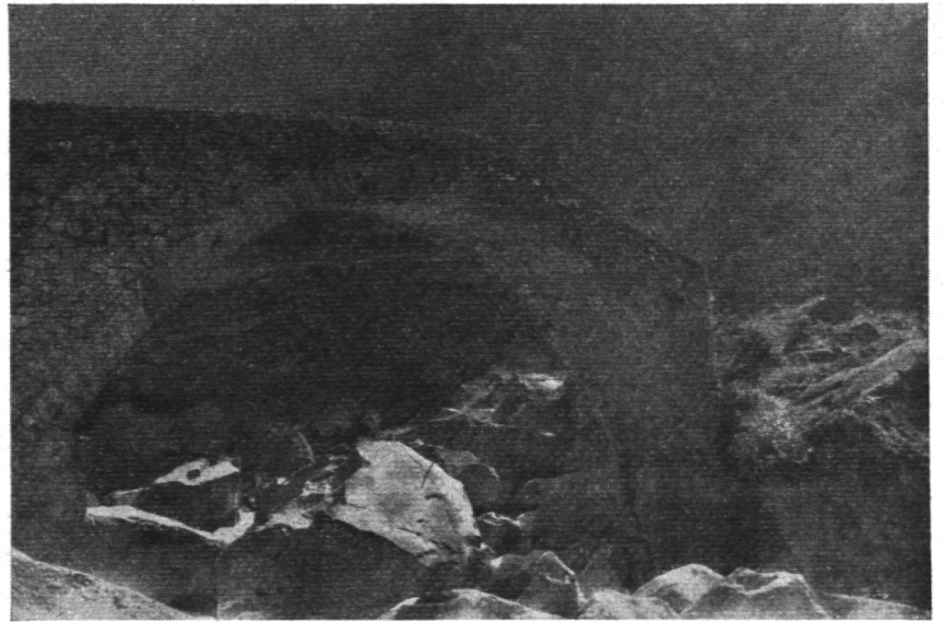
Abb. 2. Alte Reußbrücke des Gotthardsaumweges in der untern Schöllenen.
