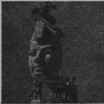
Die Felsstatuen von Abu Simbel mussten wegen des Assuan-Staudammes 65 Meter weiter nach oben unziehen. Der Transport der bis zu 30 Tonnen schweren Sandsteinblöcke war erst möglich, nachdem man mit Araldit Stahlanker eingeklebt hatte.
