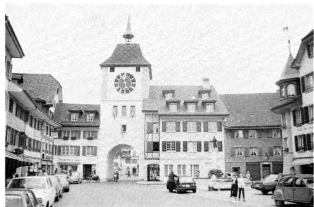
Das nach alten Plänen neu errichtete östliche Stadttor (Untertor) von Willisau.
