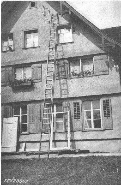
Fig. 4 Tödlicher Unfall bei Arbeit an eingeschalteter Niederspannungsleitung
