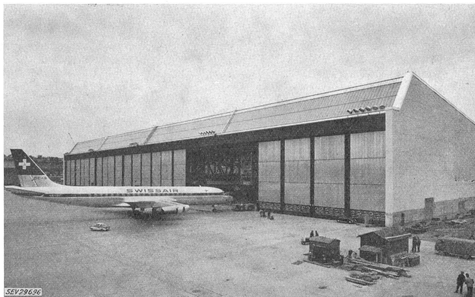
Fig. 1 Neue Werfthalle des Flughafens Kloten
