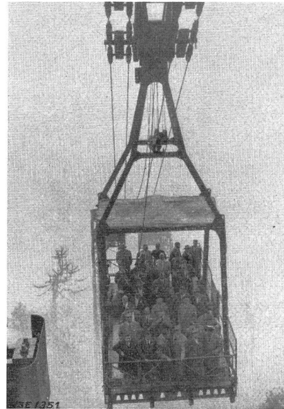
Fig. 2 Eine Besuchergruppe in der Seilbahn, die die Gäste zum Staudamm hinaufführt
