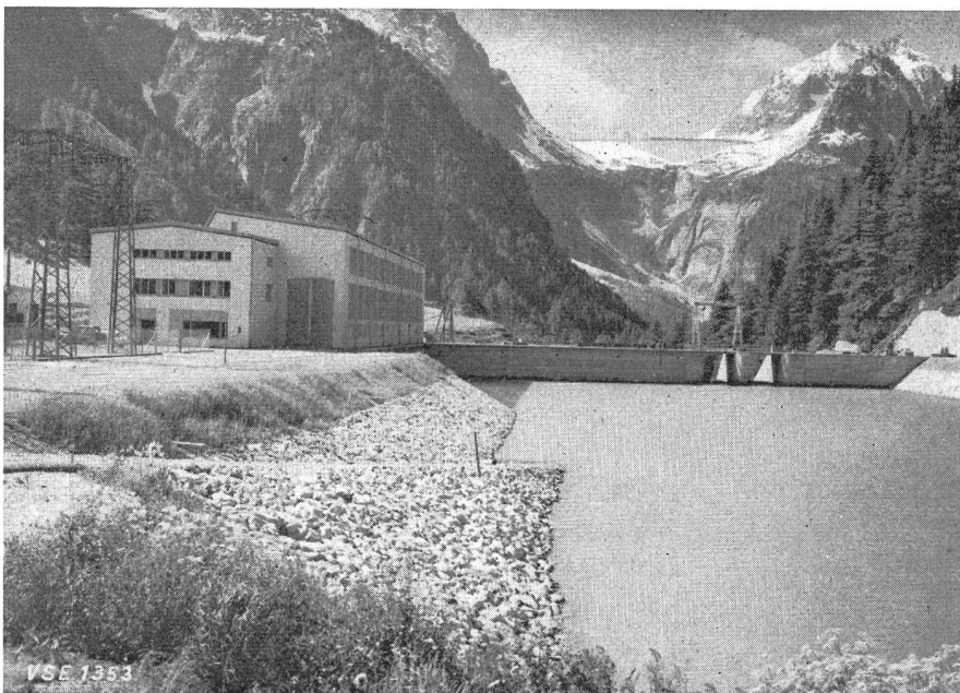
Fig. 3 Maschinenhaus und Ausgleichsbecken Löbbia
