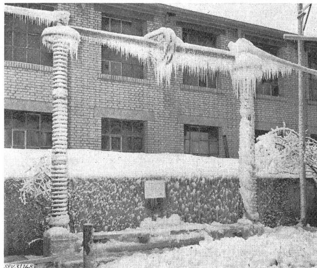
Fig. 8 Vereisungsversuch an einem 2-Säulen-Trenner 420 kV
