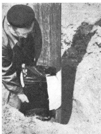
Mit gleichmässigem Zug um den Mast wickeln
