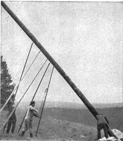
Leitungsbau im Kanton Bern mit LIFTY Stangenwinde
