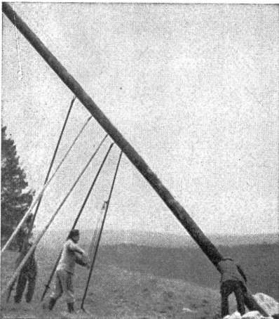
Leitungsbau im Kanton Bern mit LIFTY Stangenwinde
