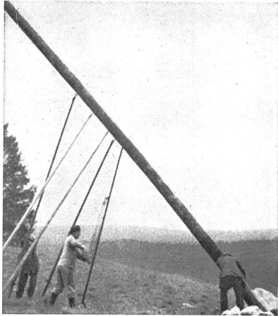
Leitungsbau im Kanton Bern mit LIFTY Stangenwinde
