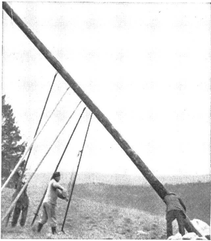
Leitungsbau im Kanton Bern mit LIFTY Stangenwinde
