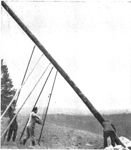
Leitungsbau im Kanton Bern mit LIFTY Stangenwinde
