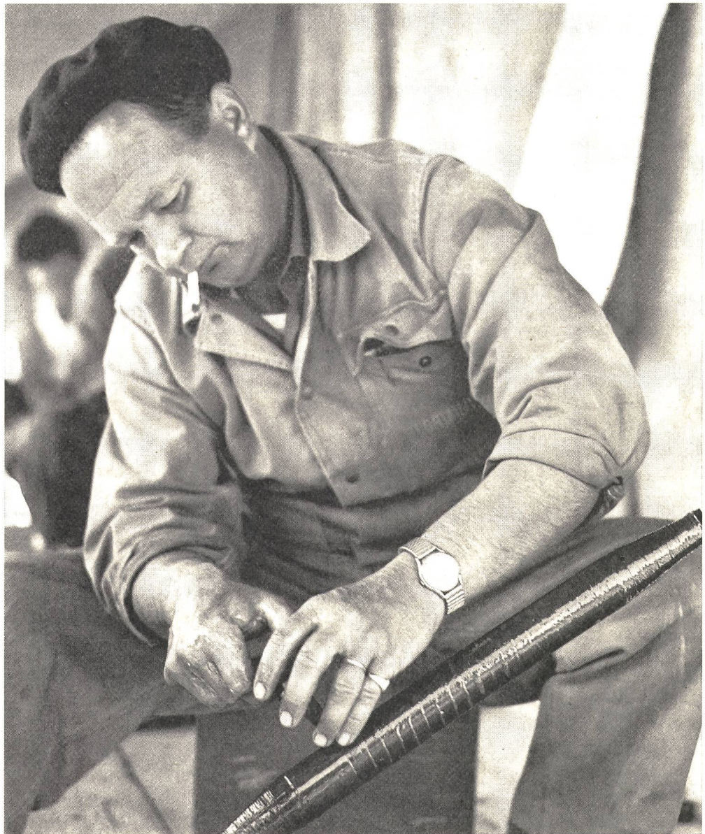
Fig. 15 Erstellung der Wickelkeule eines 50 kV-Kabelendverschlusses
