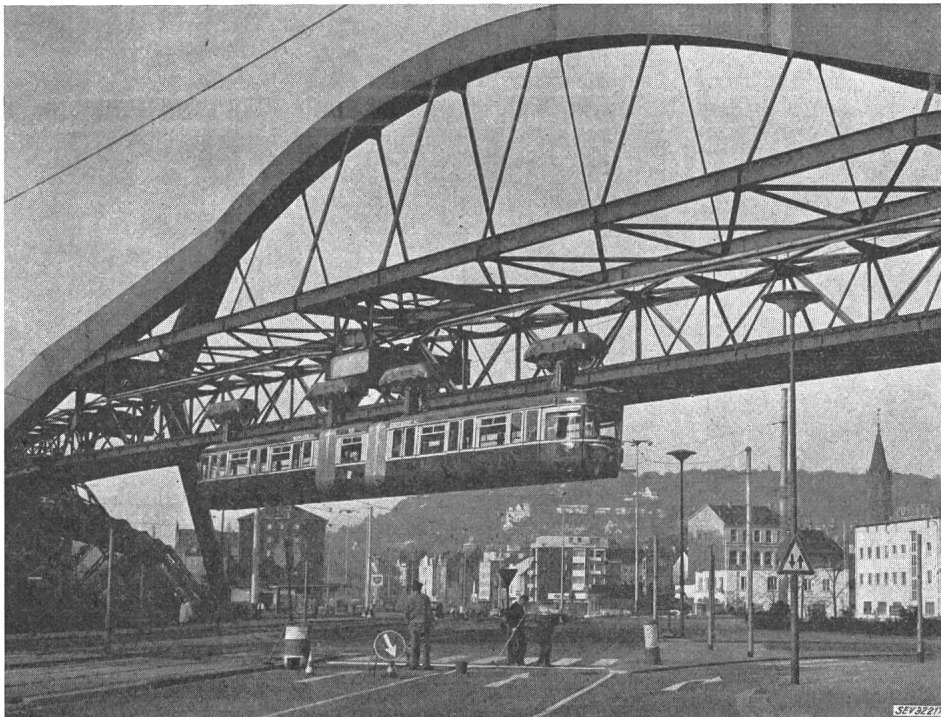
Fig. 1: Ansicht der Wuppertaler Schwebbahn an der «Ohligsmühlener Brücke»
