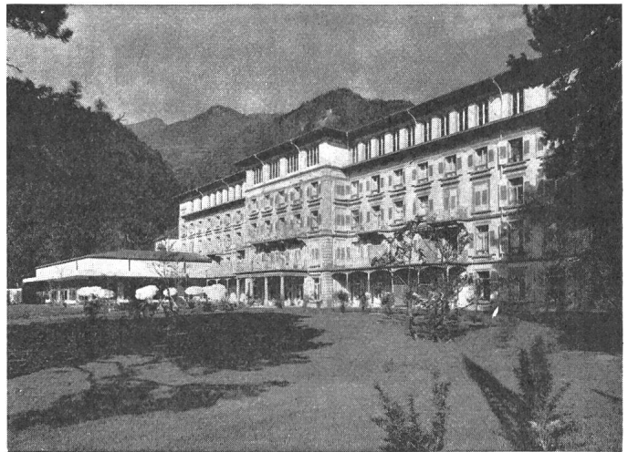
Grand Hotel «Quellenhof» Bad Ragaz. Hier heizt man angenehm und wirtschaftlich sämtliche Zimmer, Bäder, Hallen und Bäderkorridore mit Star Unity Elektro-Strahlungs-Heizung
