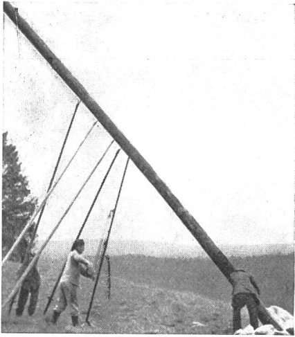
Leitungsbau im Kanton Bern mit LIFTY Stangenwinde
