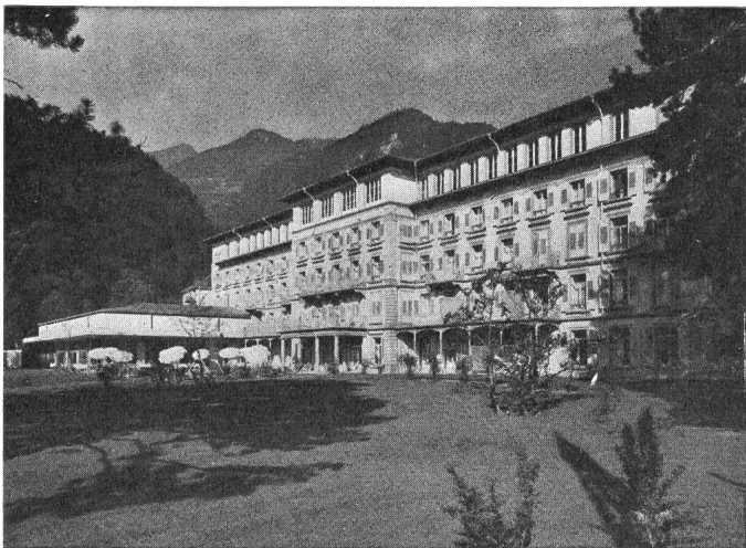
Grand Hotel «Quellenhof» Bad Ragaz. Hier heizt man angenehm und wirtschaftlich sämtliche Zimmer, Bäder, Hallen und Bäderkorridore mit Star Unity Elektro-Strahlungs-Heizung
