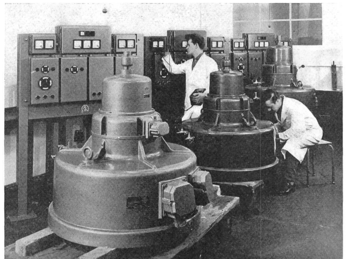
Fig. 4 Werkstatt-Abgleich von Maschinen-Generatoren mit der Grundfrequenz 20 kHz
