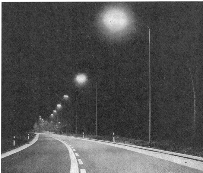
Fig. 1 Nachtaufnahme der beleuchteten Sihltalstrasse
